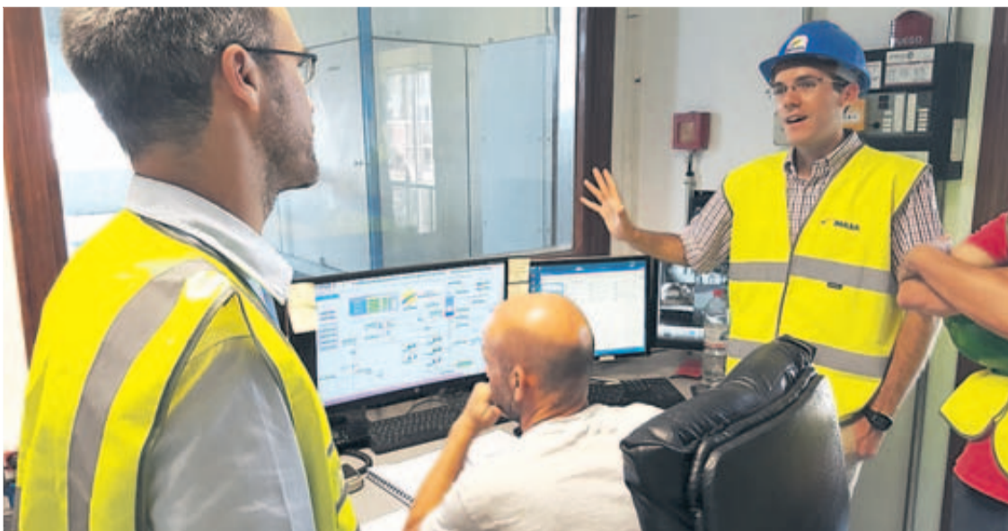
A la derecha, Javier Rubio, inventor de la tecnología, explica el funcionamiento en la sala de control de Palencia.
